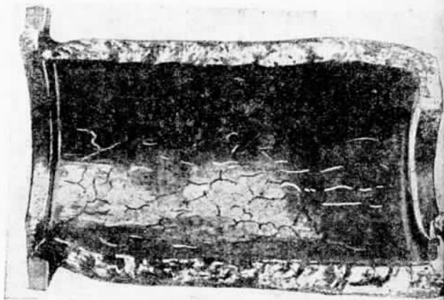
Фиг. 59. Характерные трещины на поверхности чугуновой изложницы (J. E. Hurst)
